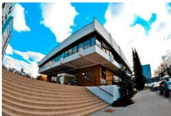
Zgrada Sveučilišnog računskog centra Sveučilišta u Zagrebu Josipa Marohnića 5, 10000 Zagreb
